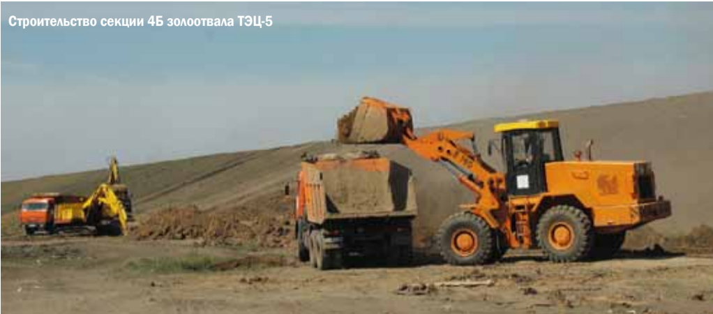
Строительство секции 4Б золоотвала ТЭЦ-5
