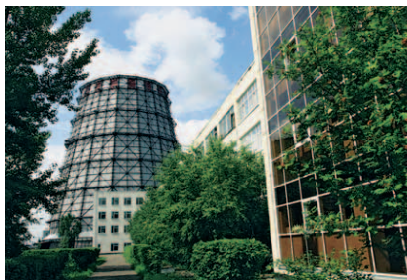
30 июня градирня № 1 ТЭЦ-5 включена в работу.
