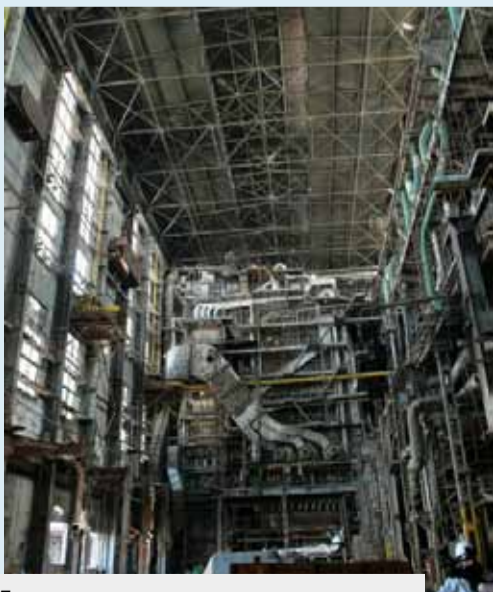
Подготовлено место установки нового котельного оборудования
